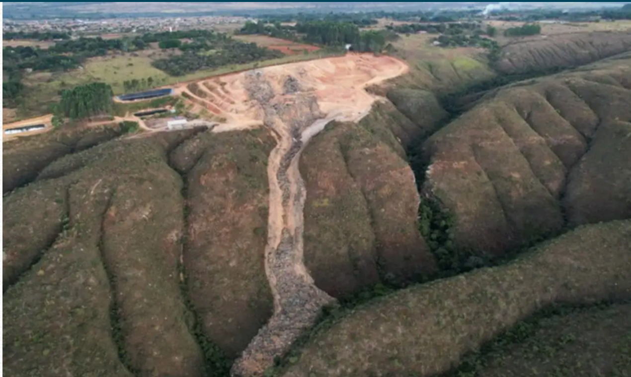
Figura 7.6 - Desmoronamento do lixão Ouro Verde em Padre Bernardo – Goiás
